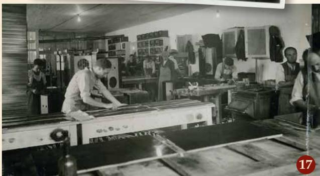
Solo successivamente (dopo il 1937), i leggìi vennero sostituiti con dei supporti metallici dotati di grosse ruote che permettevano al telaio di ruotare su se stesso in ogni momento della lavorazione. Una volta cablati i telai venivano sistemati sullo scaffale posto alle spalle delle operaie. Sotto la scala in legno un supervisore
